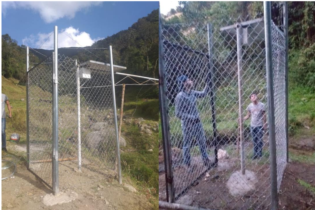
Ilustración 41: Instalación del sensor hidrológico y su encerramiento
