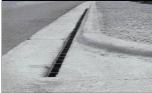
**Figura 36. Entrada de drenaje ranurada en una intersección**
